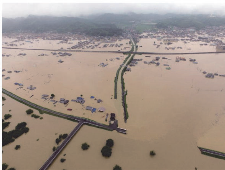
町が水の中に・・・屋根まで浸かった家も多数ありました(最高深度は5.8mとされています)
